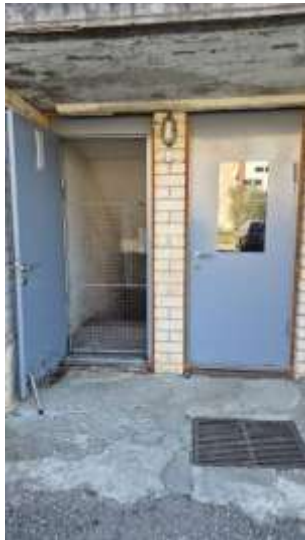
Kāpņu telpas ārdurvis
